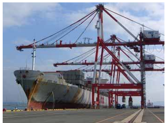
ひびきコンテナターミナル
