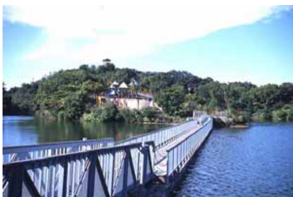
瀬板の森公園
